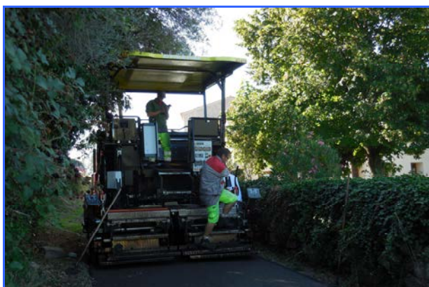
Travaux de goudronnage
