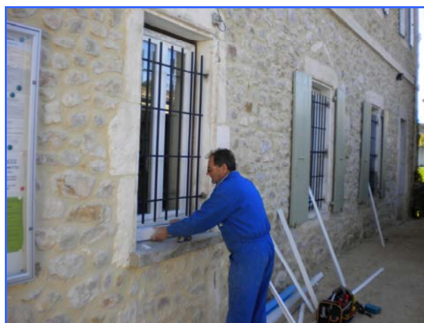
Réfection des menuiseries
